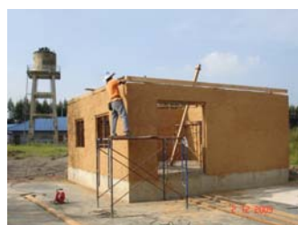
ขึ้นโครงหลังคาแล้ว
