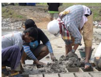
ย่ำดินได้ทีแล้วนำมาอัดเป็นก้อน
