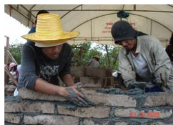
ได้ก้อนดินแล้วมาช่วยกันก่อผนัง
